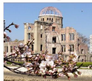
อะตอมมิดบอมบโดม
