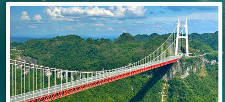
สะพานอ้ายจ้าย
