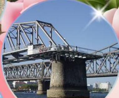
สะพานขาดตานตง
