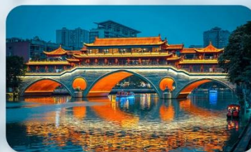
สะพานอันชุน
