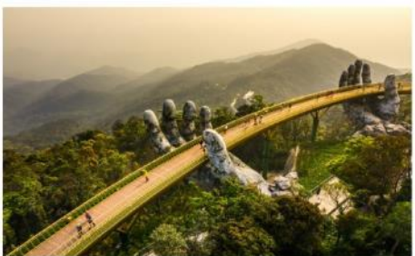
สะพานลอยฟ้า Golden Bridge
