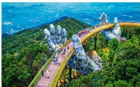
สะพานลอยฟ้า Golden Bridge
